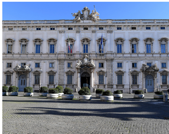
Palazzo della Consulta (fonte cortecostituzionale.it)
